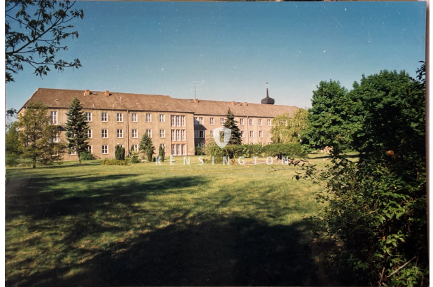
*Ansicht von Parkfläche aus - Aufnahme aus 2006
