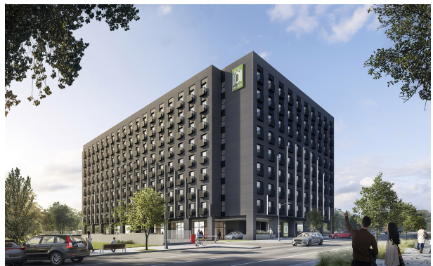
H101-Madrid Exterior Facade v3 02
